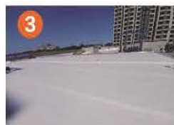
平铺铺设长效复合排水板
