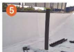
安装透气观察管
