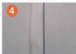
土工布长短边搭接处粘接
