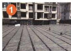
基层清理，按图纸定位规划弹线 铺设双面自粘卷材
