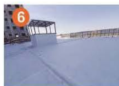
红吸排水槽上铺设土工布
