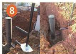
安装红吸排水槽、安装观察井
