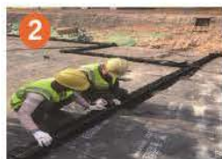
铺设红吸排水槽
